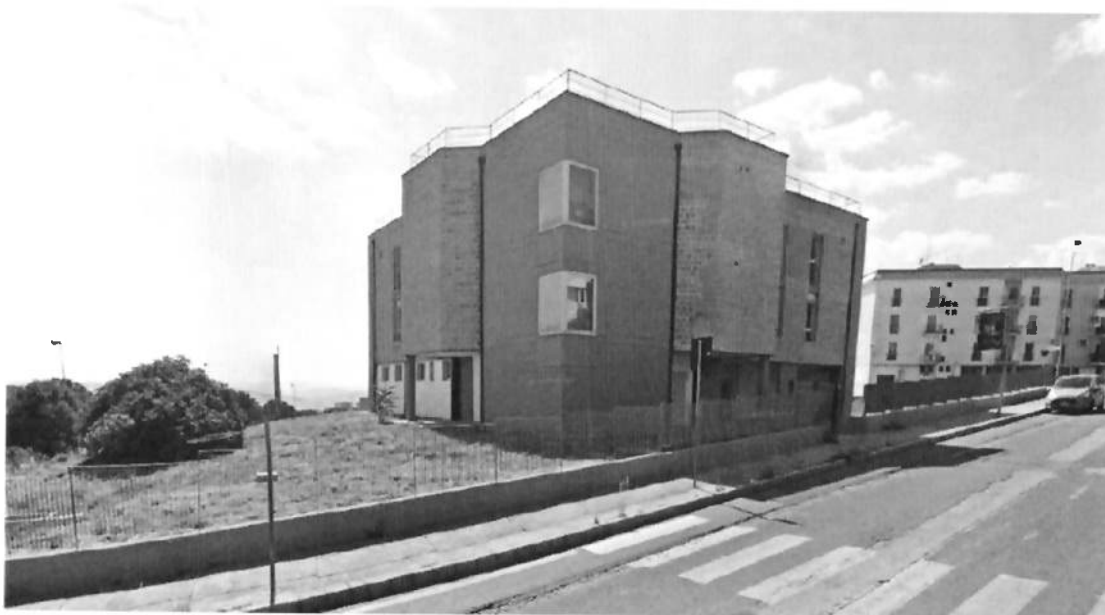
Fig. 1 _ Fabbricato interessato – Via Benedetto Croce 21
