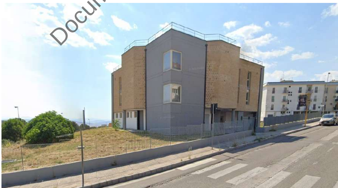
Fig. 1 _ Fabbricato interessato – Via Benedetto Croce 21
