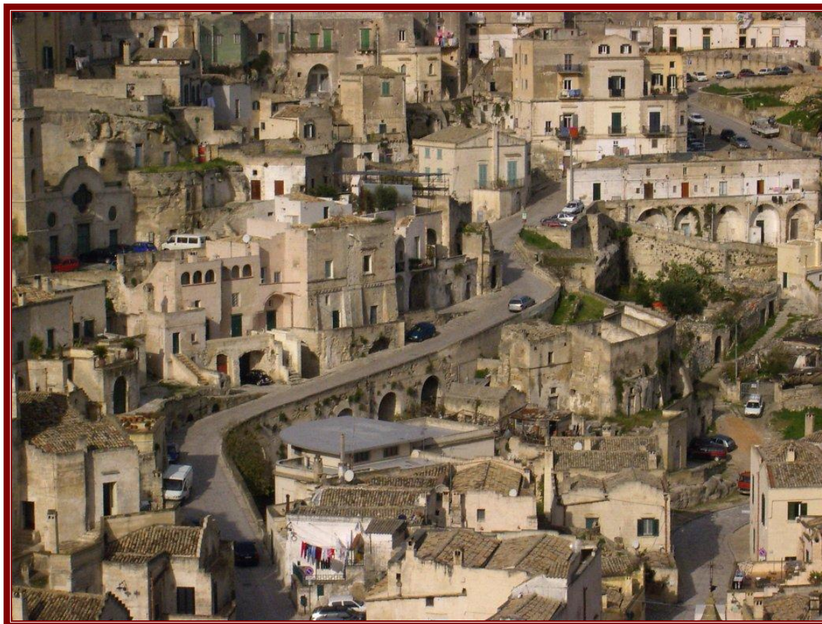
Fig.1) Interventi di recupero nel "Sasso Barisano"
