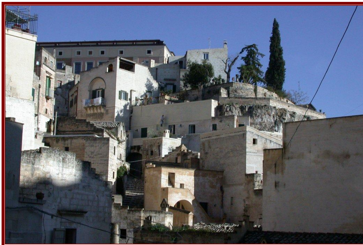
Fig.2) Interventi di recupero nel "Sasso Barisano"
