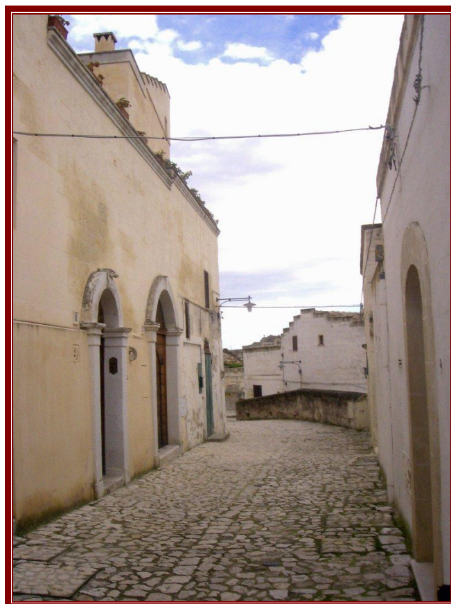
Fig.20) Rifacimento delle urbanizzazioni in via S. Rocco nel Sasso Barisano
