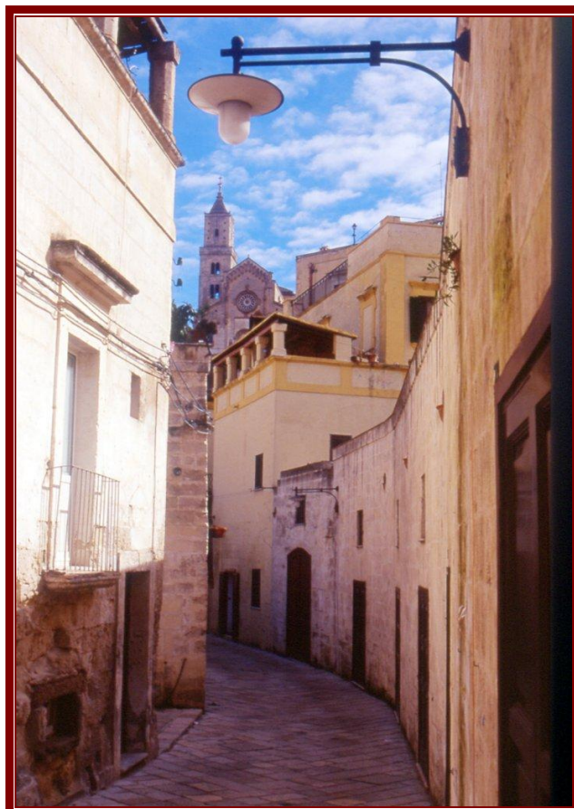
Fig.18) Rifacimento delle urbanizzazioni in Via Fiorentini nel Sasso Barisano
