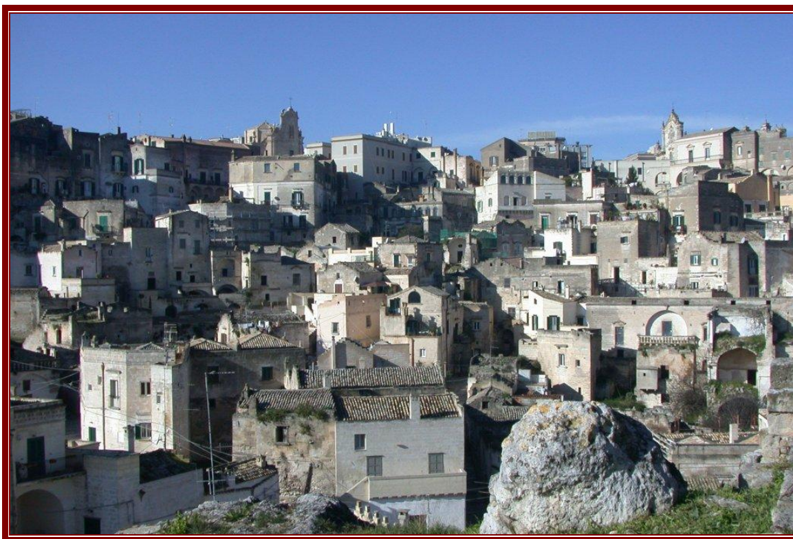
Fig.4) Interventi di recupero nel "Sasso Caveoso"
