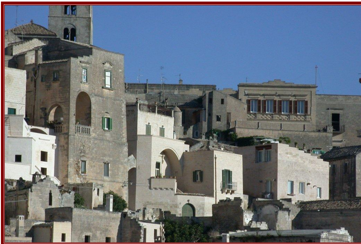
Fig.3) Interventi di recupero nel "Sasso Caveoso"
