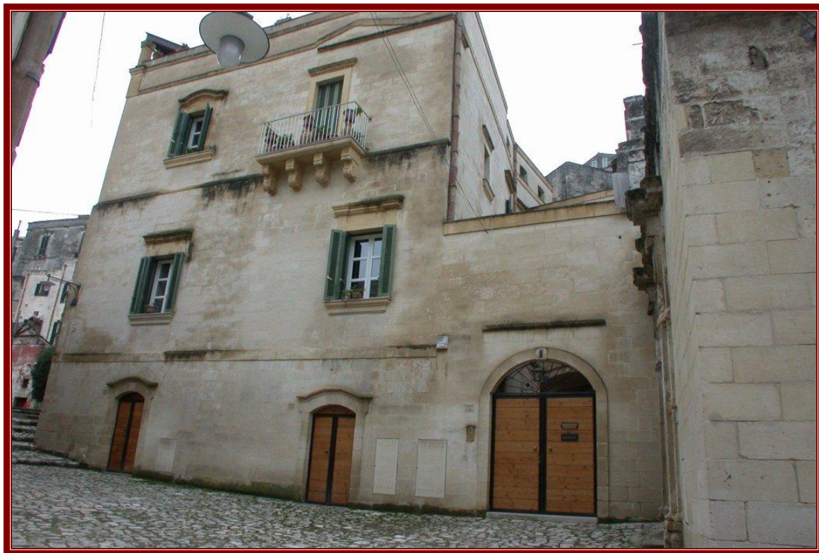
Fig.5) Recupero di una casa palazzata ad uso residenziale nel "Sasso Barisano"
