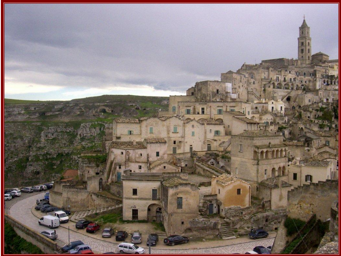
Fig.13) Attività di servizio nel Sasso Barisano (Complesso del Casale – call center)
