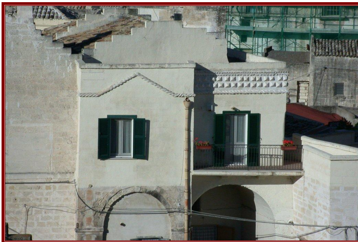
Fig.7) Intervento di recupero ad uso residenziale nel "Sasso Caveoso"
