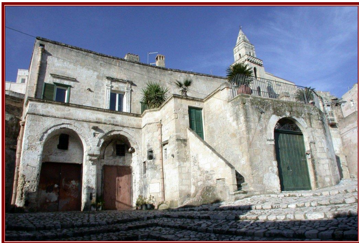
Fig.6) Recupero di una casa a corte ad uso residenziale nel "Sasso Barisano"
